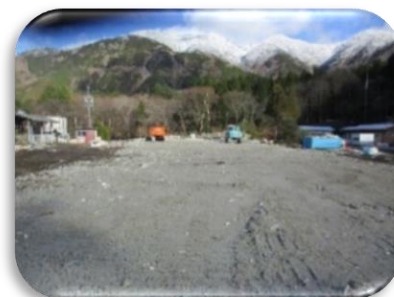
【解体された旧広濟寮】
